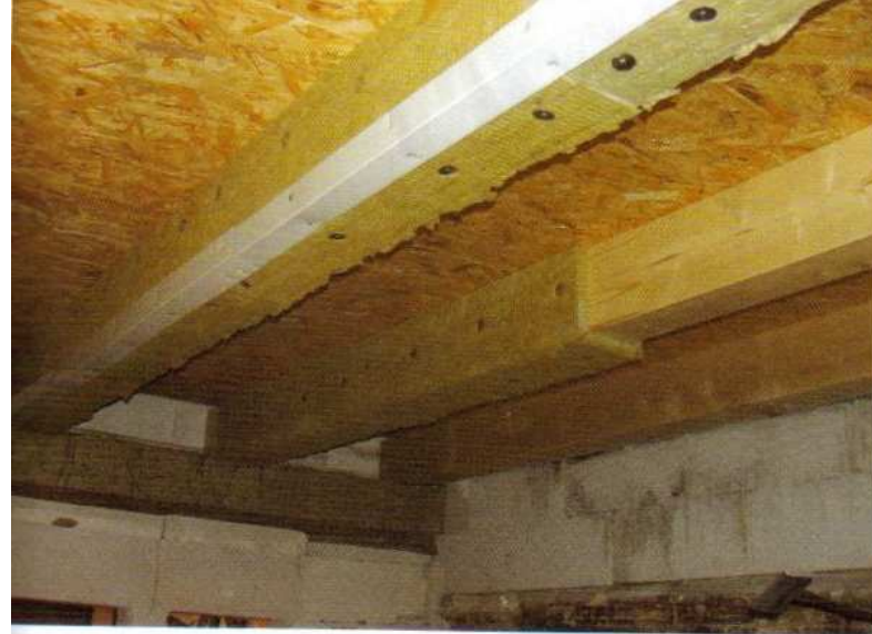
▲ Obr. 2. Protipožární obklad nosných trámů přímo na místě zkoušky
