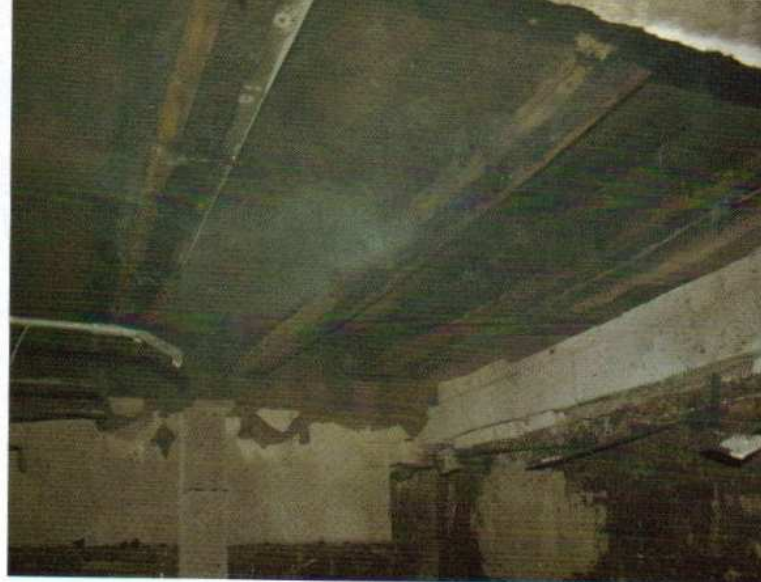
▲ Obr. 3. Pohled do pece po ukončení zkoušky
